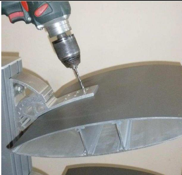
10. Das Vorbohren und Vernieten führen Sie analog für die restlichen Lamellenverbindungen durch.
